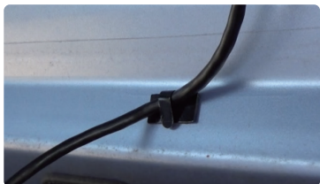
⑨ クリップで車内へ傷つけず簡単に配線
