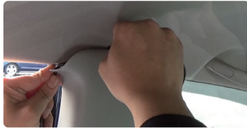
⑪ センターピラーに配線
