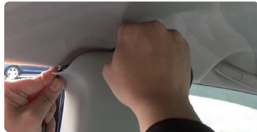
⑪ センターピラーに配線
